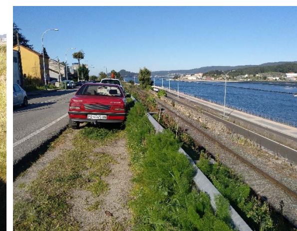
Imagen donde se puede observar la vía férrea y las carreteras PO-546 y PO-12
